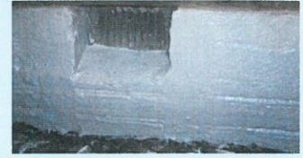
▲ FA-R工法 アラミドロッドで補強後パワーアラストを塗布。
