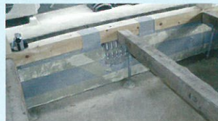
▲ FA-S工法 パワーアラストで劣化補修した基礎にアラミド繊維シートで補強後パワーアラストを塗布。
